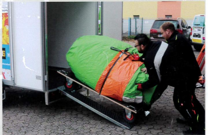
Den Spanngurt lösen, den MK vom Transportwagen herunterheben und entrollen.
